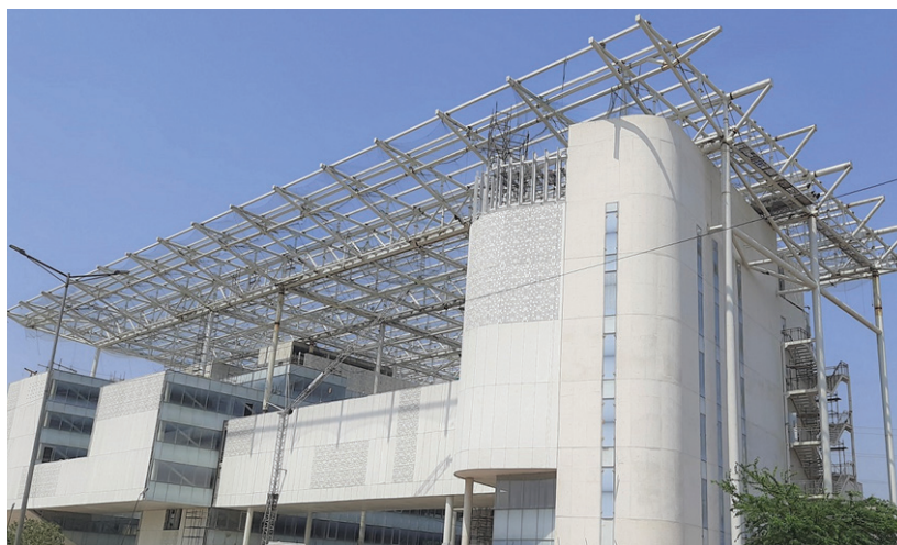
गुरुग्राम में आरईसी की निर्माणाधीन स्टेट-ऑफ-द-आर्ट बिल्डिंग
