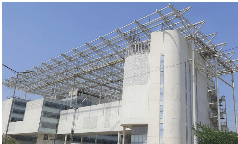
गुरुग्राम में आरईसी की निर्माणाधीन स्टेट-ऑफ-द-आर्ट बिल्डिंग
